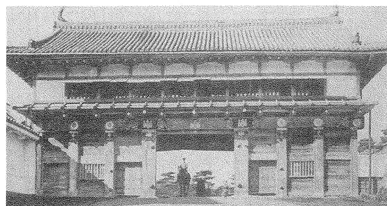
23 仙台城大手門古写真(突き揚げ戸を開放した状態)
