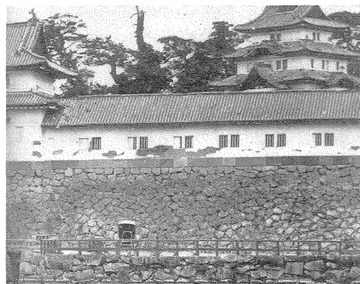
36 土壁が直線になって落ちることはない。写真は江戸城(『古写真でみる失われた城より』二〇〇〇より)
