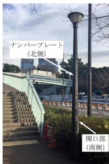
図 5-2 調査対象とした照明柱の設置状況
