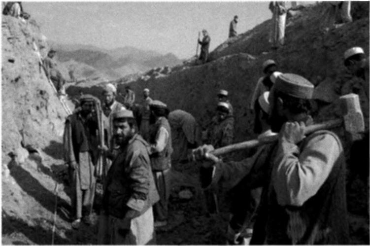
達作業員現地に従事する工用水路建設
