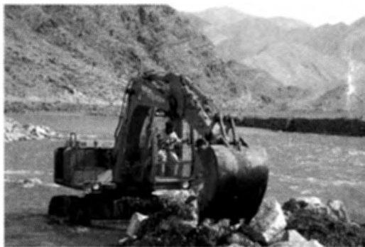
中村自ら重機を操り工事の陣頭に立った
