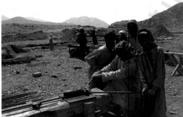
用水路建設現場では日本人、アフガン人がともに汗を流す
