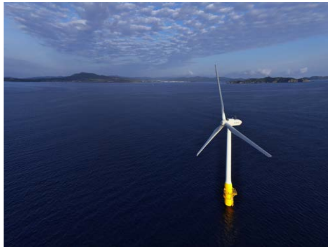
図 5-5. 環境省実証にて建設された 2MW 浮体式洋上風力発電システムの概観
