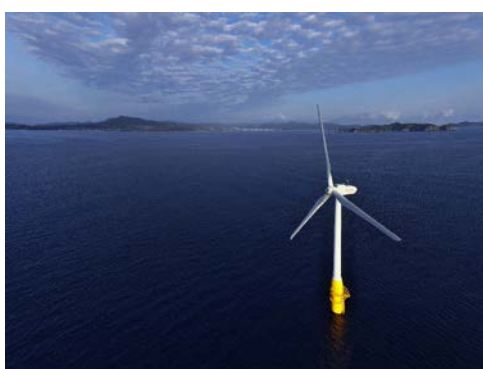
図 2-3. 環境省実証事業にて実証された 2MW 浮体式洋上風力発電システム
