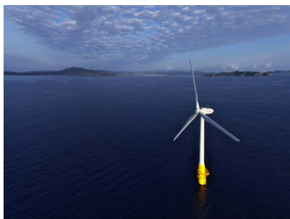
図 6-9. 環境省実証にて建設された 2MW 浮体式洋上風力発電システムの概観
