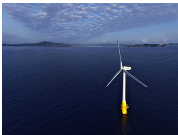
図 4-6. 環境省実証にて建設された 2MW 浮体式洋上風力発電システムの概観
