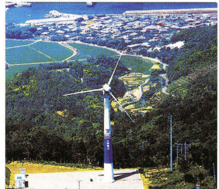
(c)C風力発電所
