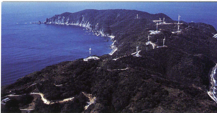
(b)B風力発電所
