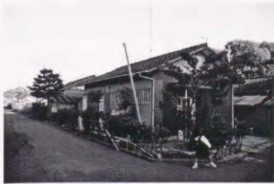
写真 2.4.5 老朽化した簡平タイプの住宅
