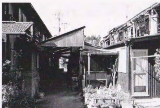
写真2.4.2 隣棟間隔が狭く、増築を繰り返している炭鉱住宅
