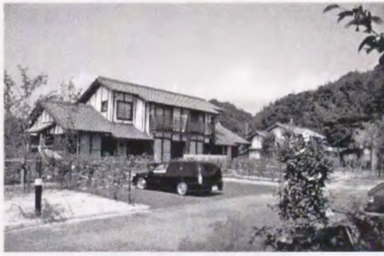
写真 2.4.8 山田市の木造 2 戸 1 住宅
