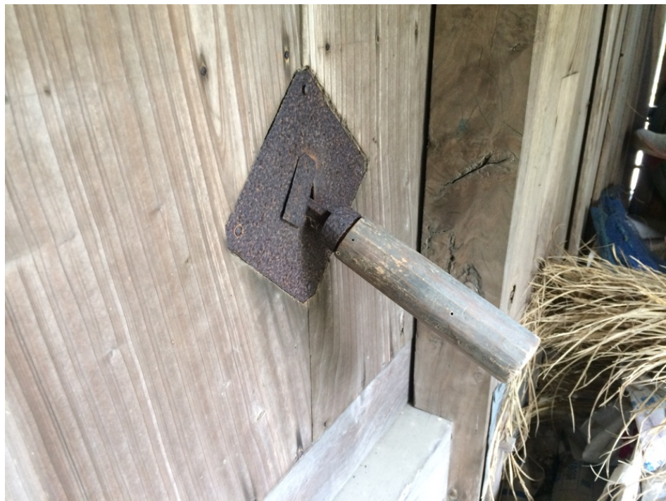
写真 2 扉に挿入された状態の鍵 (豊玉町卯麦集落)
