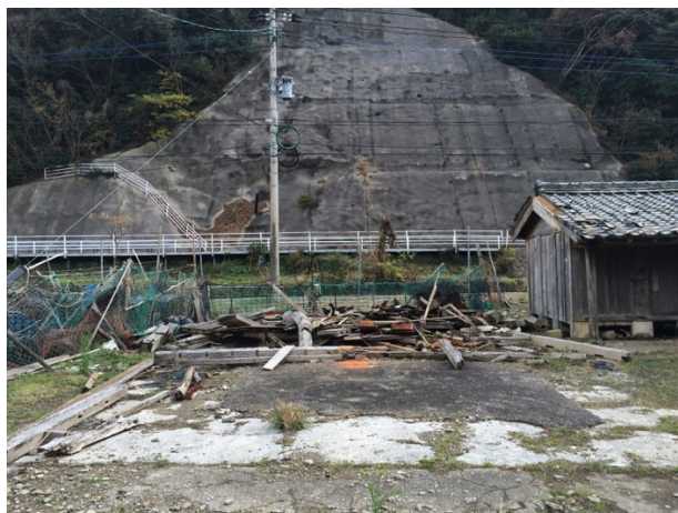
写真 9 瓦に葺き替えられた石屋根と撤去された石屋根のコヤ
