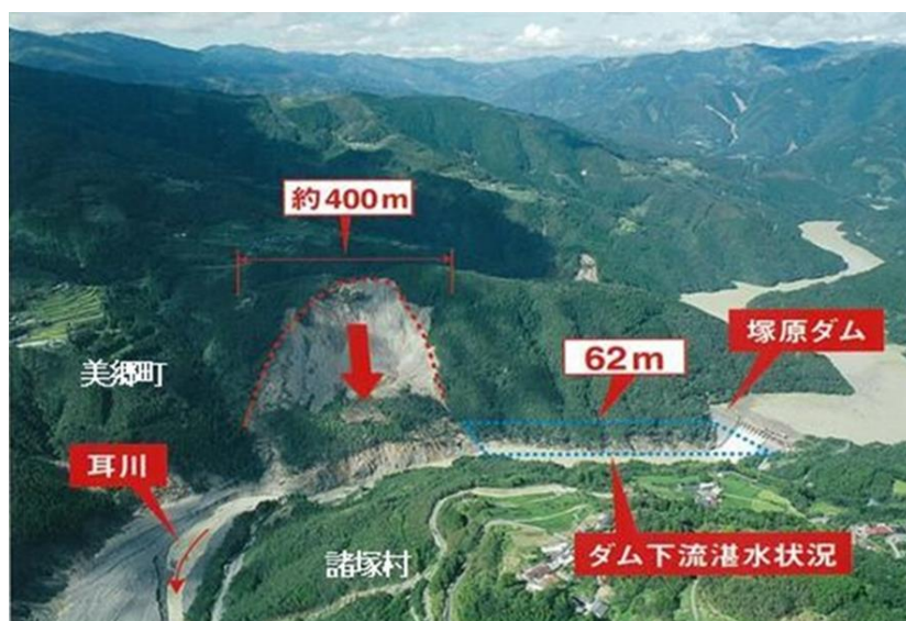
図 2-6 塚原ダム直下の崩壊
