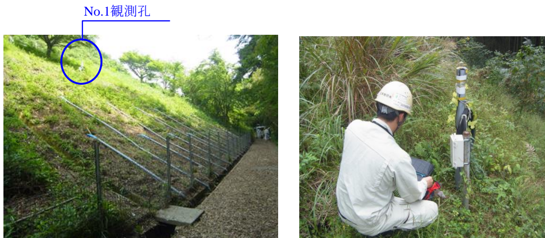
写真-5.3 地下水位計の設置状況 (No.1観測孔)
