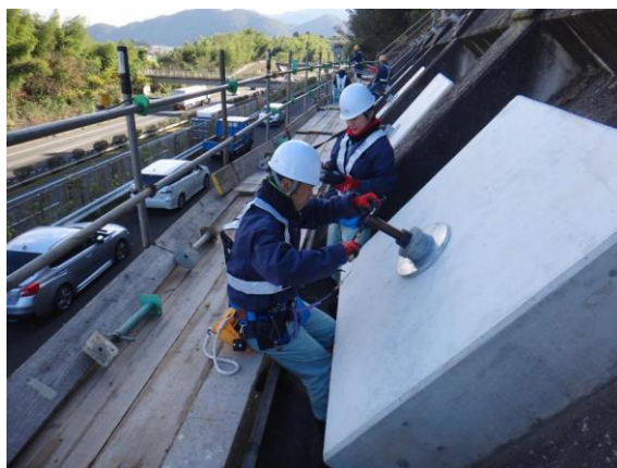
写真-3.3 のり面における現地診断状況例
