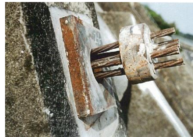
b) コンクリートキャップ撤去
