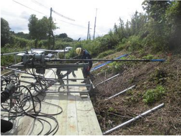
(1) 補強対策状況
