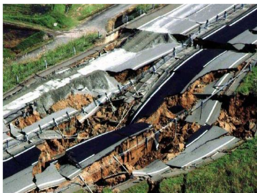
(1) 新潟県中越地震による被災状況
