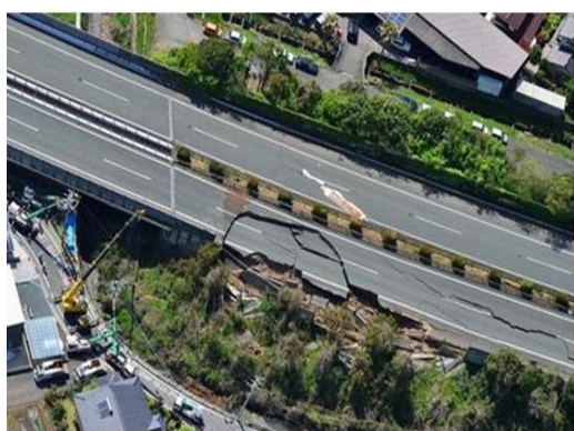
(3) 熊本地震による被災状況
