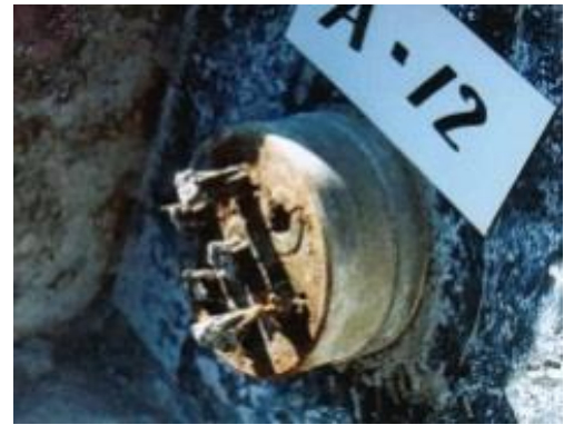
(2) アンカーの引込み
