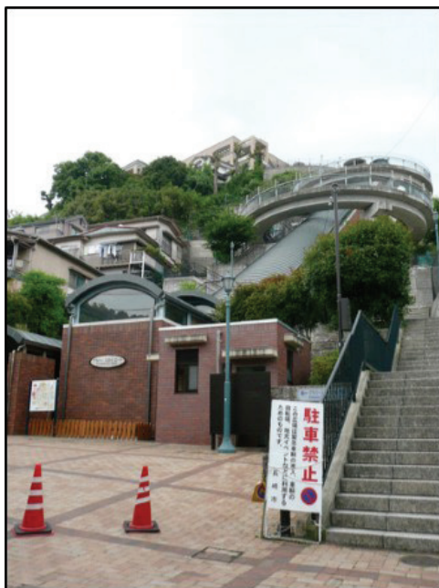
図 3-17 斜行エレベーター
