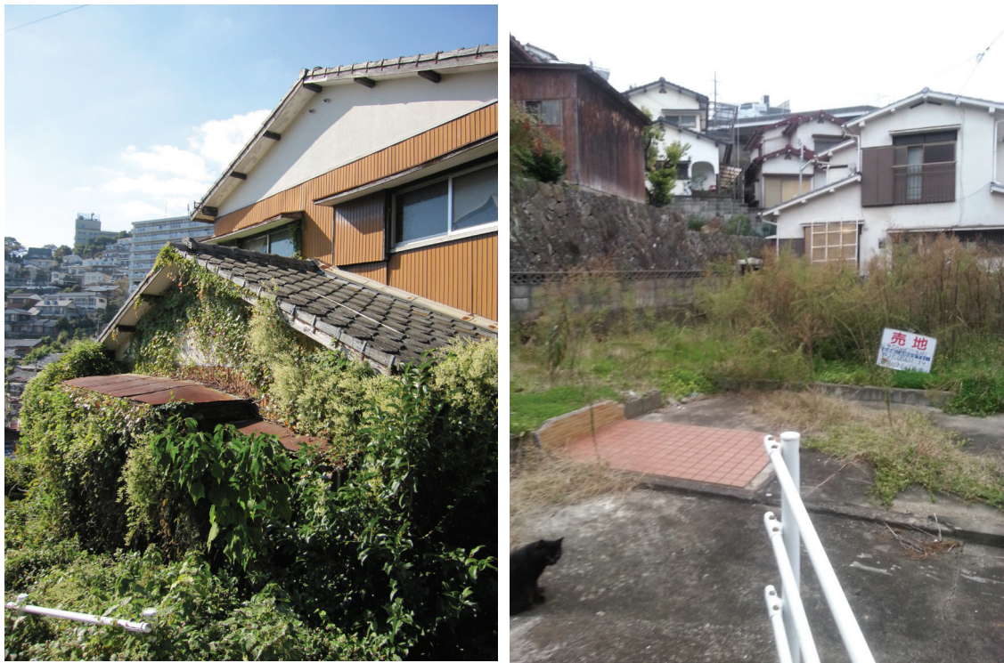
図2-5 長崎市斜面市街地における空き家・空き地
