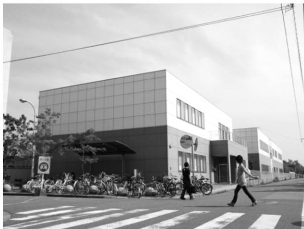
図2-3 法科大学院棟全景
