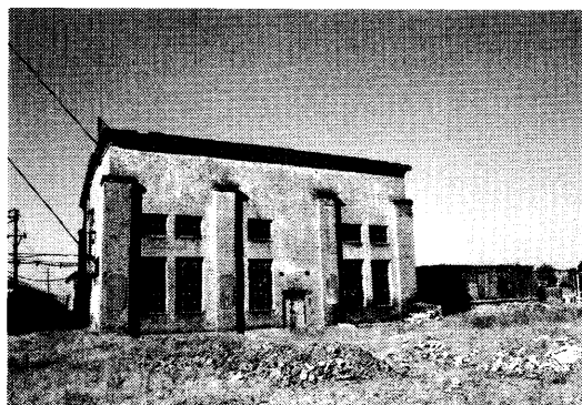
西堅坑捲揚機室
