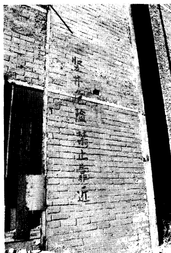
煉瓦と鉄骨の状態
